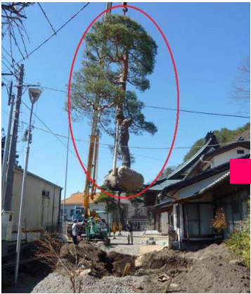
クレーン車で吊り上げました。
